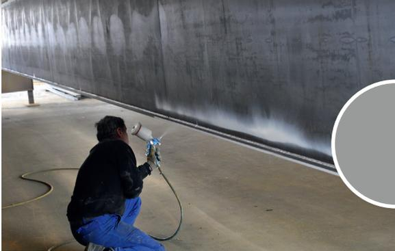
Um höchsten Korrosionsschutz (z.B. nach ISO 12944) im Stahlbau zu gewährleisten wird fast ausschließlich mit 2-komponentigen Epoxy-Grundierungen und PU-Decklacken höchster Qualität lackiert.
